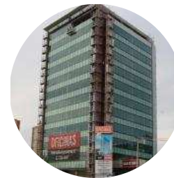
2011 Edificio San Andres Oficinas Concepción
