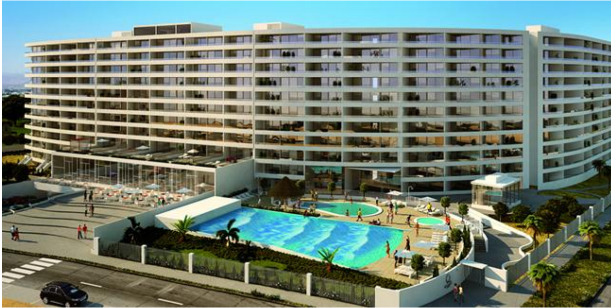
Obra: Edificio Aqua La Serena Mandante: Inmobiliaria Inmobilia Duración: 18 meses Adjudicación: 2S13 Pisos: 11
