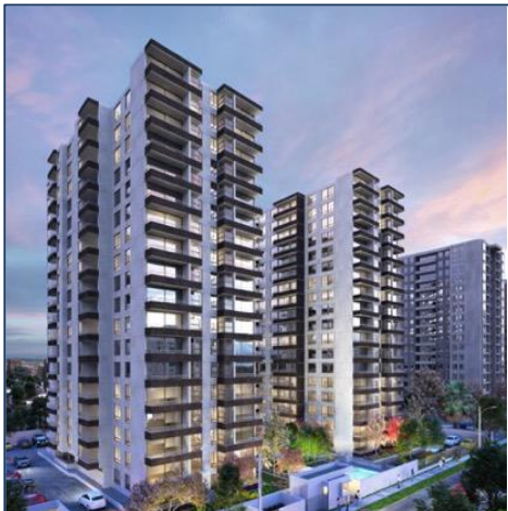
Armando Moock, Macul - Ingevec En construcción (50%)
