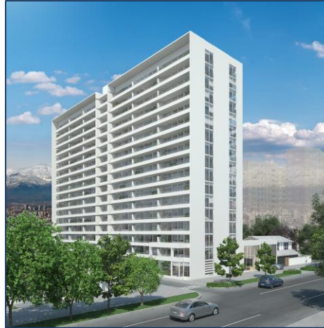
Vicuña Mackenna, La Florida - Ingevec En construcción (50%)
