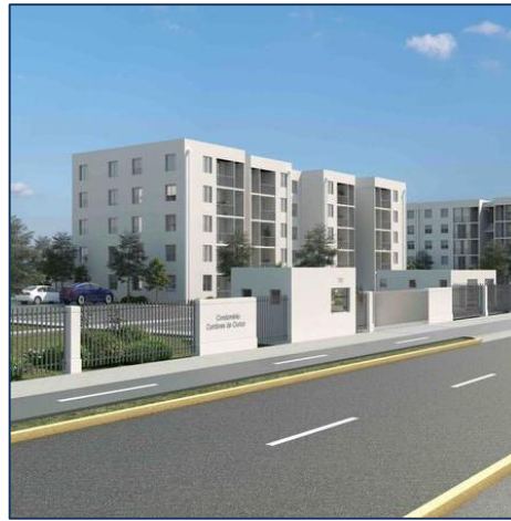
Cumbres de Curicó (DS19) - Ingevec En construcción (50%)
