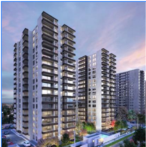
Armando Moock, Macul - Ingevec En construcción (50%)
