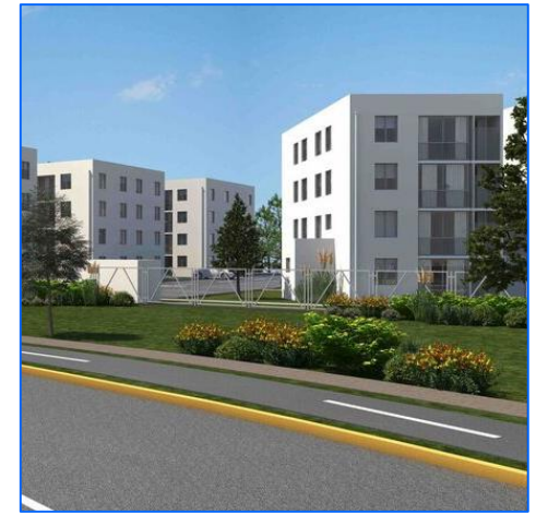
Terrasol Chillán (DS19) - Ingevec En construcción (50%)
