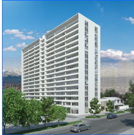
Vicuña Mackenna, La Florida - Ingevec En construcción (50%)
