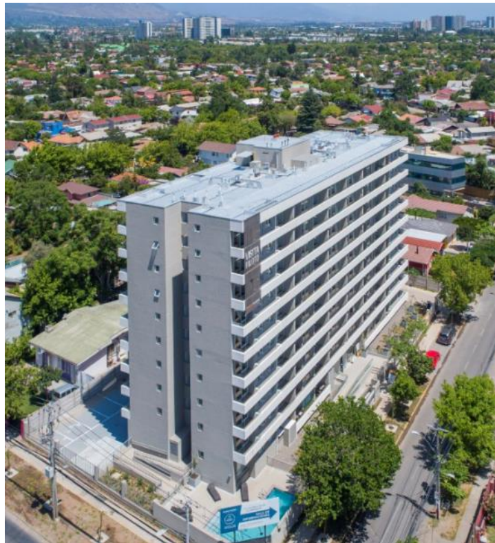
Edificio Mirador La Florida
