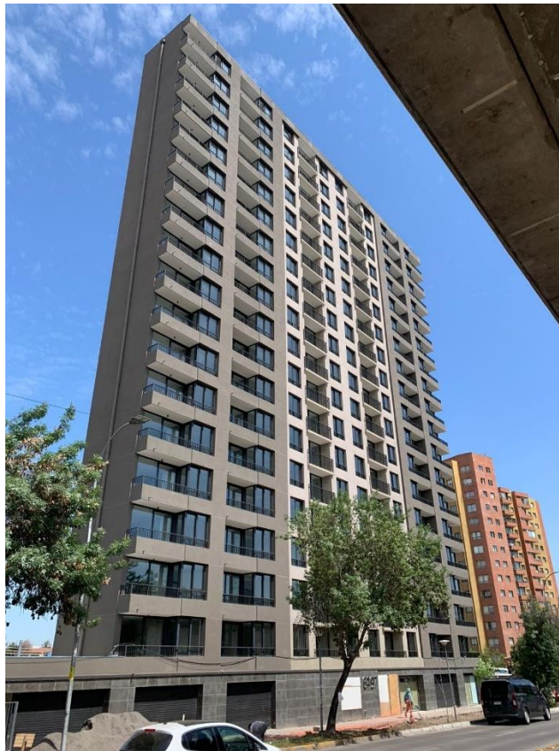
Edificio Mirador Azul Fondo de Desarrollo para Renta Residencial LV - Ingevec
