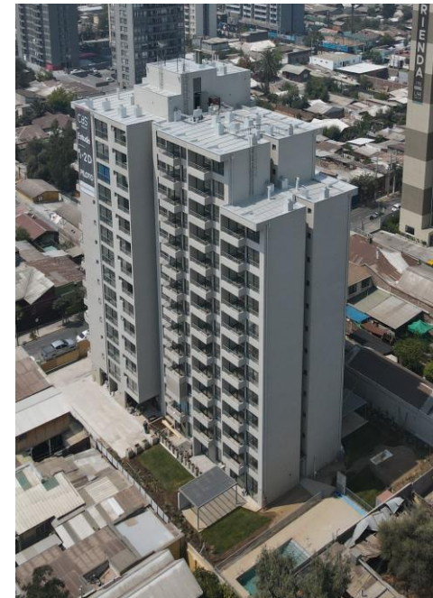
EDIFICIO JOSÉ URETA INMOBILIARIA INGEVEC
