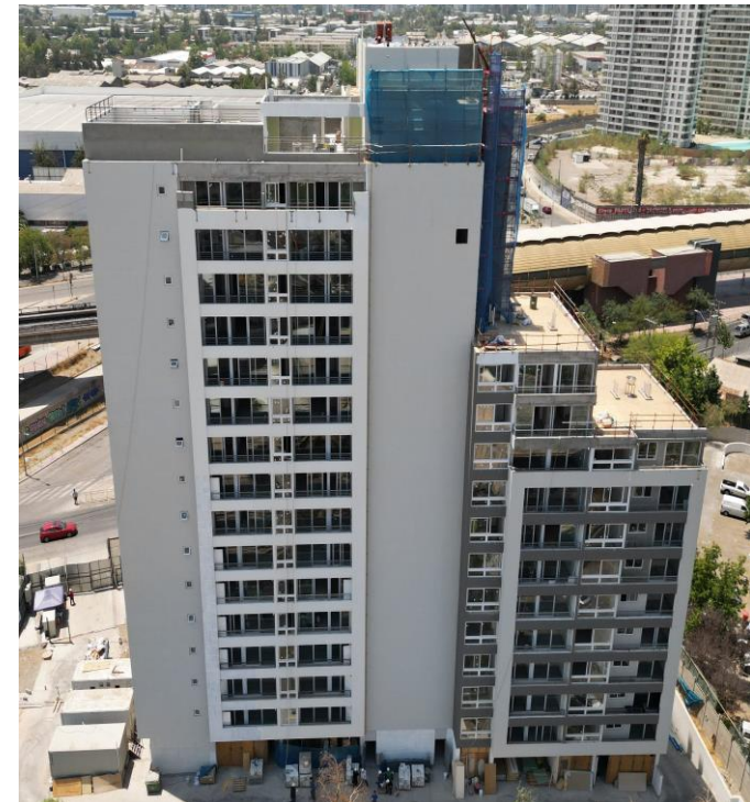
EDIFICIO CARLOS VALDOVINOS SAN JOAQUÍN
