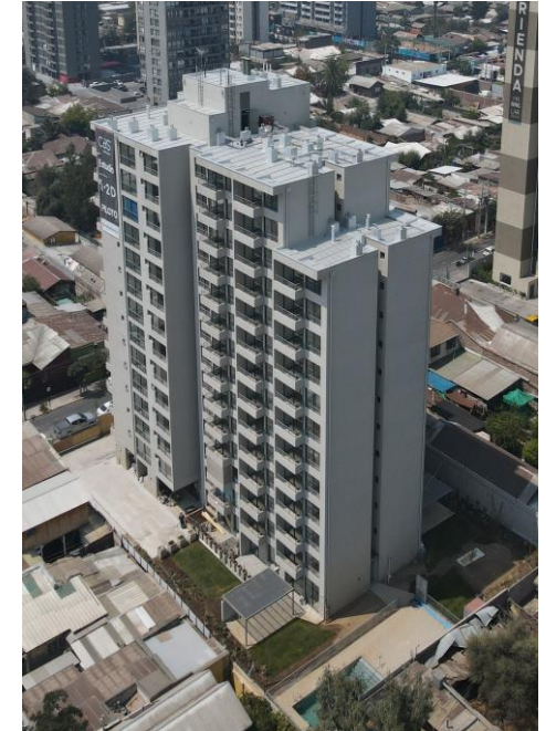
EDIFICIO JOSÉ URETA INMOBILIARIA INGEVEC
